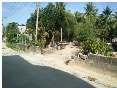
村庄围墙改造前
